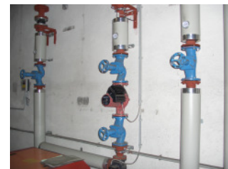
Dämmung der Leitungen
